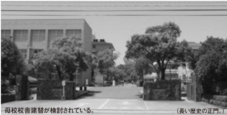
母学校舎建替が検討されている。
